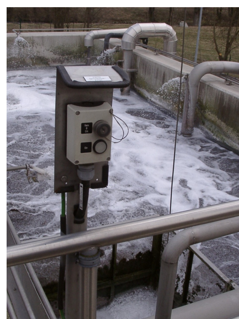
Abbildung 2: MBBR-Anlage
